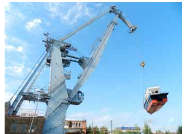
Экипаж СПГ-43/83 выполняет погрузку катера для ремонта.
