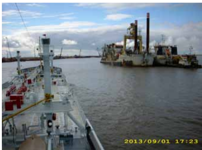
Дноуглубительные работы ведутся в акватории порта Сабетта.
