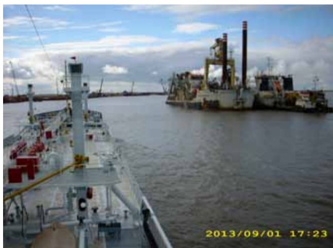
Дноуглубительные работы ведутся в акватории порта Сабетта.
