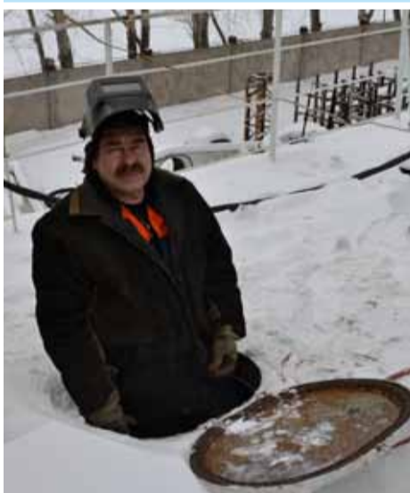
Иван Николаевич Кугаевских выполняет монтаж трубопровода.
