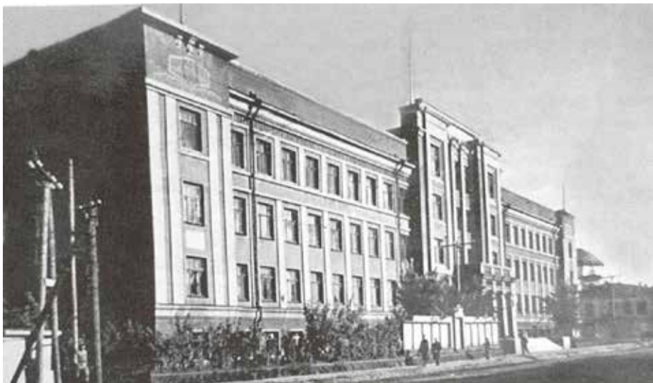
Здание Управления речного пароходства. Фото 1947 года.
