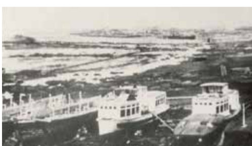
Отремонтированный и подготовленный к началу навигации 1920 года омский флот.
