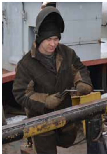
Сварочными работами на палубе занят электросварщик Андрей Владимирович Грабовский.
