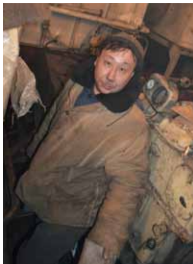
Слесарные работы по монтажу трубопровода в машинном отделении выполняет трубопроводчик Тлеуберды Амангельдинович Оспанов.
